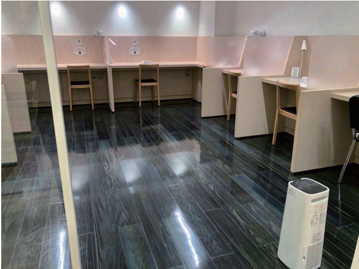
2012年 徳島市民ギャラリー / 重歩行対応用フローリング 藍染杉 Tokushima City Library in 2012 / WPC flooring Indigo Cedar wood
