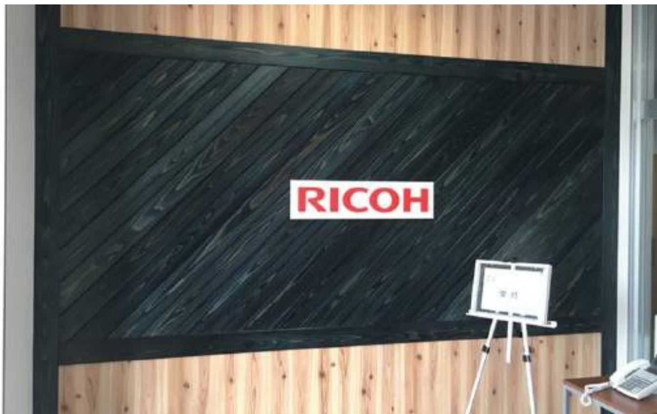
2019年 企業エントランス / 藍染杉 羽目板 *準不燃仕様 (Semi-noncombustible material) Company Office Entrance in 2019 / Indigo Cedar Wood Panel board
