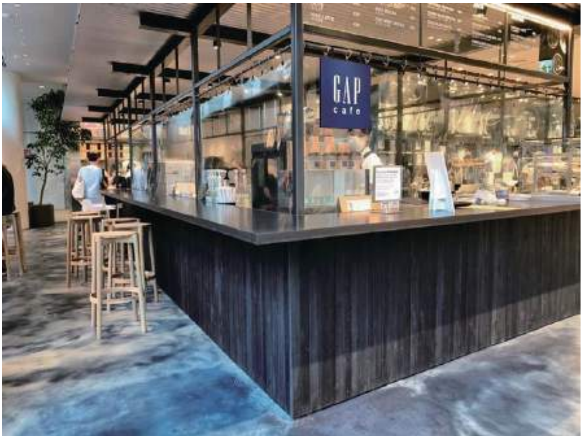
2020年 GAP 新宿フラッグス店 内装 / (上) 藍染スレート材 *不燃仕様、(下) 腰板 藍染古材 GAP Shinjuku Flags shop in Tokyo in 2020 / Indigo Dyed Slate、Indigo Dyed Re-used
