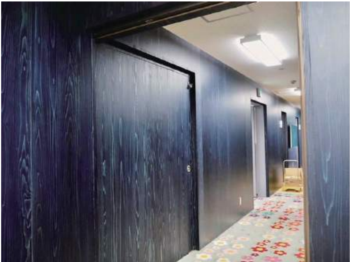
2020年 デジタルコンテンツ会社 社内スペース用 / 藍染杉 ダイライト化粧材 *不燃仕様 (Non-combu Digital content company space in 2020 / Indigo Dyed Cedar Wood Decarative Wall P
